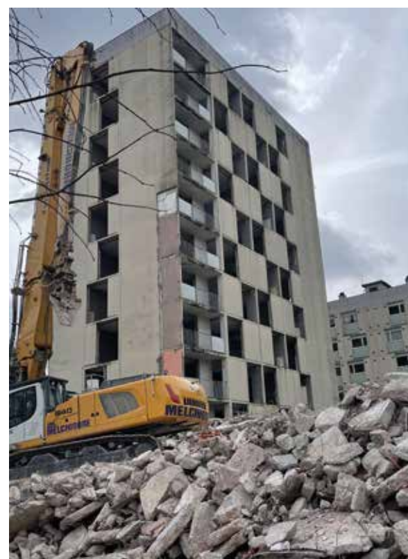
La 3 e phase de déconstruction a commencé
