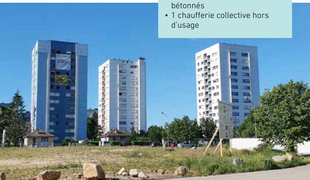
→ « LES CANARIS », « LES PICVERTS » ET « LES TOURTERELLES » ONT ÉTÉ DÉSAMIANTÉS.
