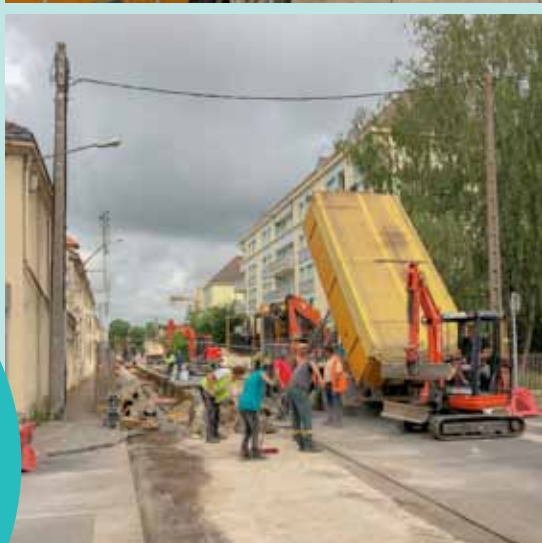
→ ON SAFFAIRE À LA RÉNOVATION ET À L'EXTENSION DU RÉSEAU.
